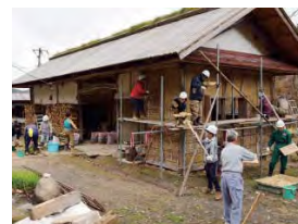
二度の大震災で壊れた地域の特徴的な長屋門を修復する復古創新プロジェクト。職人と一緒に自分たちで修復することで、地域文化を学ぶ。
